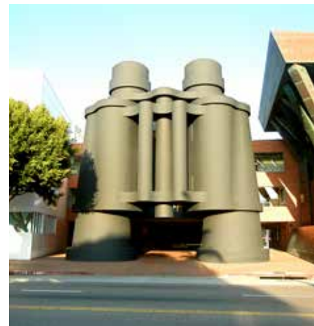
Frank Gehry, Claes Oldenburg e Coosje van Bruggen Edificio Binocolo, Los Angeles, 1984
