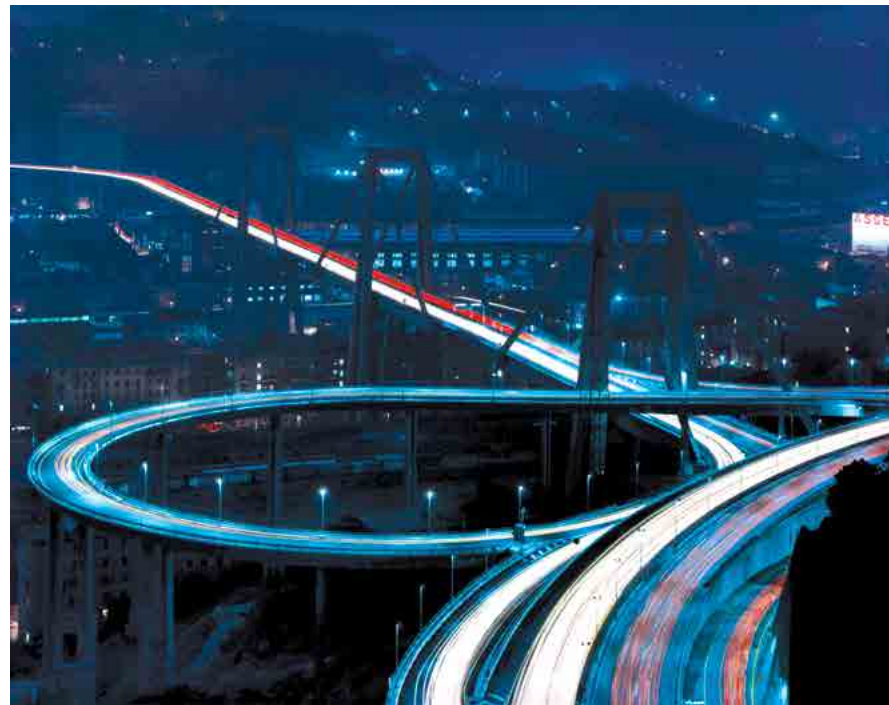
Viadotto sul Polcevera, autostrada Genova-Savona, 1967 © Archivio Publifoto Intesa Sanpaolo
